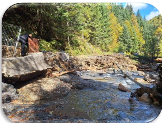
Oštećenje zbirne kaptaže izvorišta Zdravo vrelo (Foto: Ć. Šarić, 2024.)
