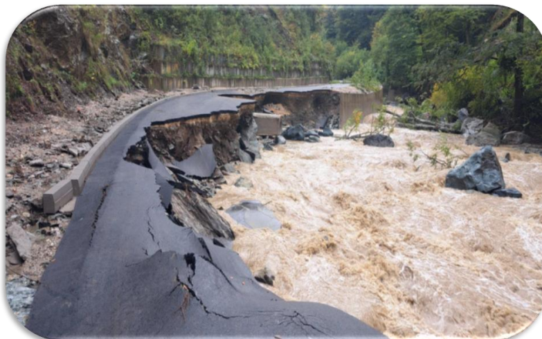
Oštećenja putne infrastrukture na području općine Fojnica (put za Dusinu) (Foto: Č. Šarić, 2024.)
