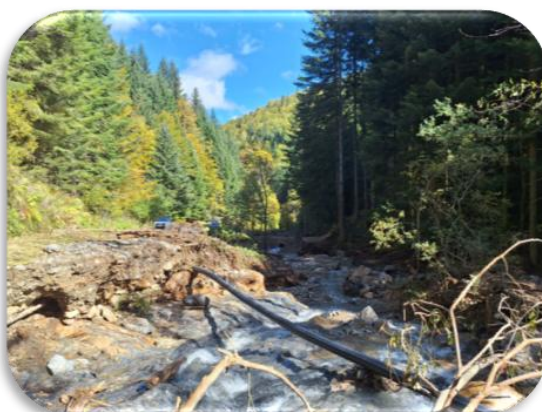
Oštećenje zbirne kaptaže izvorišta Zdravo vrelo (Foto: Ć. Šarić, 2024.)
