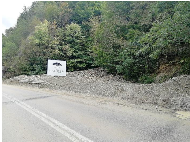
Slika 50. i 51. Nanos materijala i mjesto otkinute mase od koje je krenuo blatni tok
