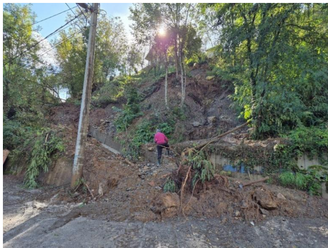
Slike 16 i 17. Klizište i odron iznad regionalnog puta R437 u mjestu Glodnica
