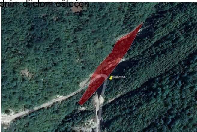
Slika 36. Pozicija kameno-blatnog toka koji je ošteti i zatrpa propust
