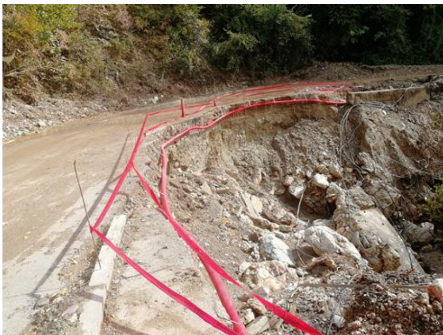
Slika 48. Aktivirano klizno tijelo ispod puta
